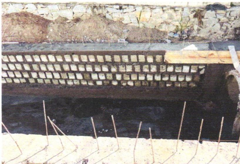
**FOTO 08 - ALVENARIA DE VEDAÇÃO DE BLOCOS VAZADOS DE CONCRETO DE 9X19X39CM (ESPESSURA 9CM DE OAREDES COM ÁREA LIQUIDA MAIOR OU IGUAL A 6M2**
