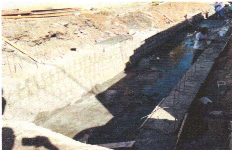
**FOTO 07 – ALVENARIA DE VEDAÇÃO DE BLOCOS VAZADOS DE CONCRETO DE 9X19X39CM (ESPESSURA 9CM DE OAREDES COM ÁREA LIQUIDA MAIOR OU IGUAL A 6M2**
