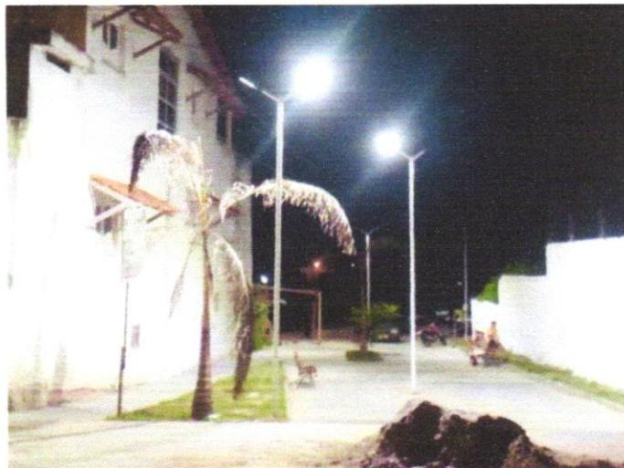
**FOTO 06 - LUMINARIA EM LED PARA ILUMINAÇÃO PÚBLICA, 302, BIVOLT, SELO A INMETRO, CORPO EM ALUMINIO**
