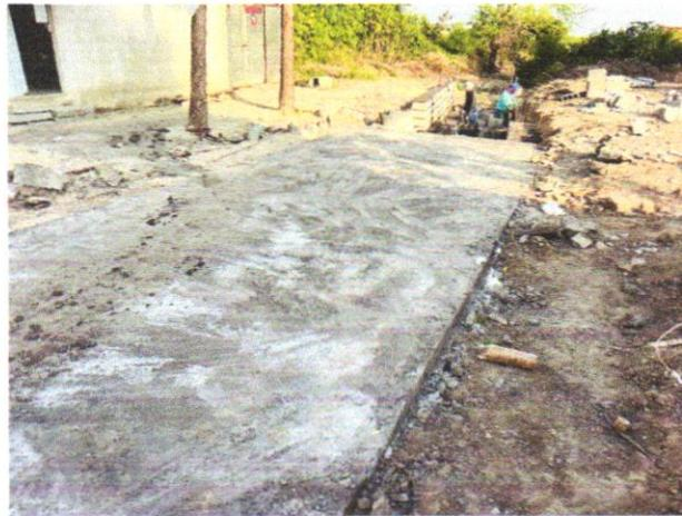
**FOTO 01 – PISO EM CONCRETO 20MPA PREPARO MECÂNICO . ESPESSURA 7CM..**
